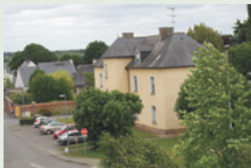
Restauration rue du Presbytère.
